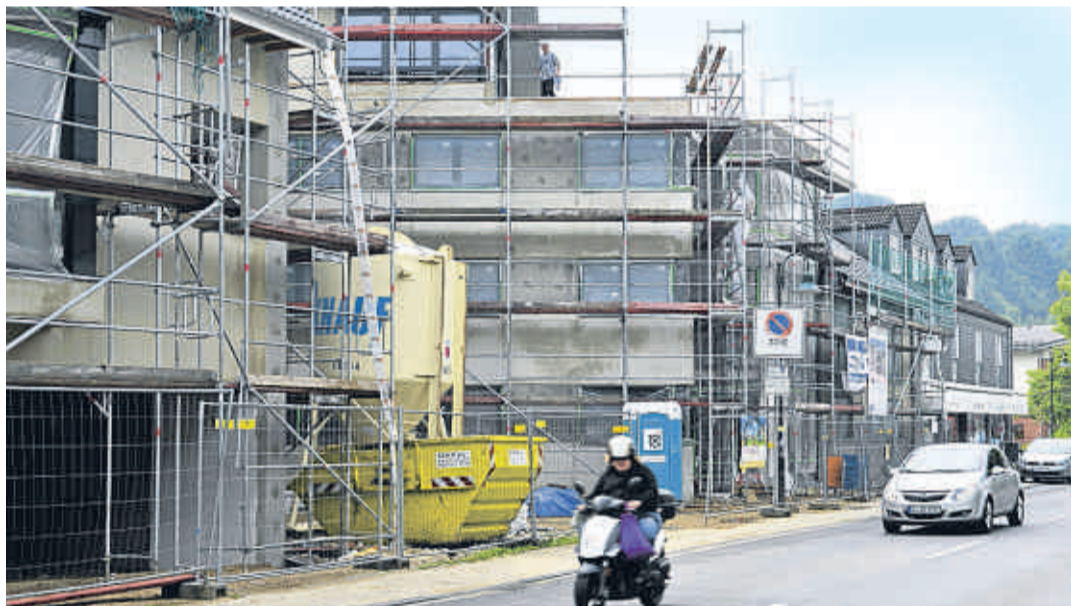
Anstelle eines kleinen Druckerei-Gebäudes entsteht ein Haus mit 18 Wohnungen.
