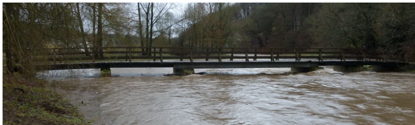
das war knapp: Brücke am Sülzbogen am 13.01.2011
